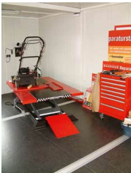
Im Inneren ist eine komplette Werkstatt-ausrüstung für zwei Monteure installiert.
